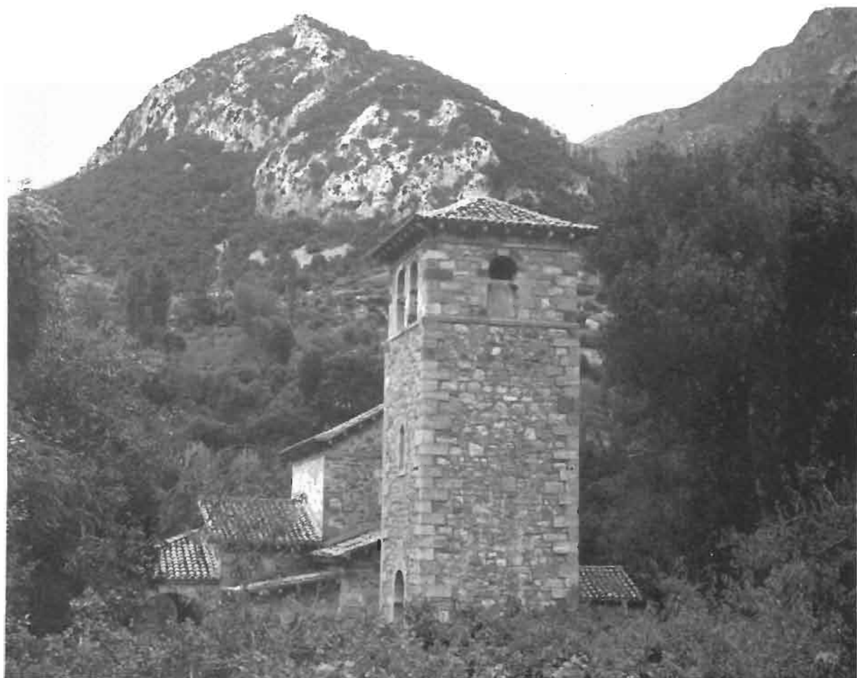
Lám. 9. Exterior. Escalonamiento de las cubiertas.
