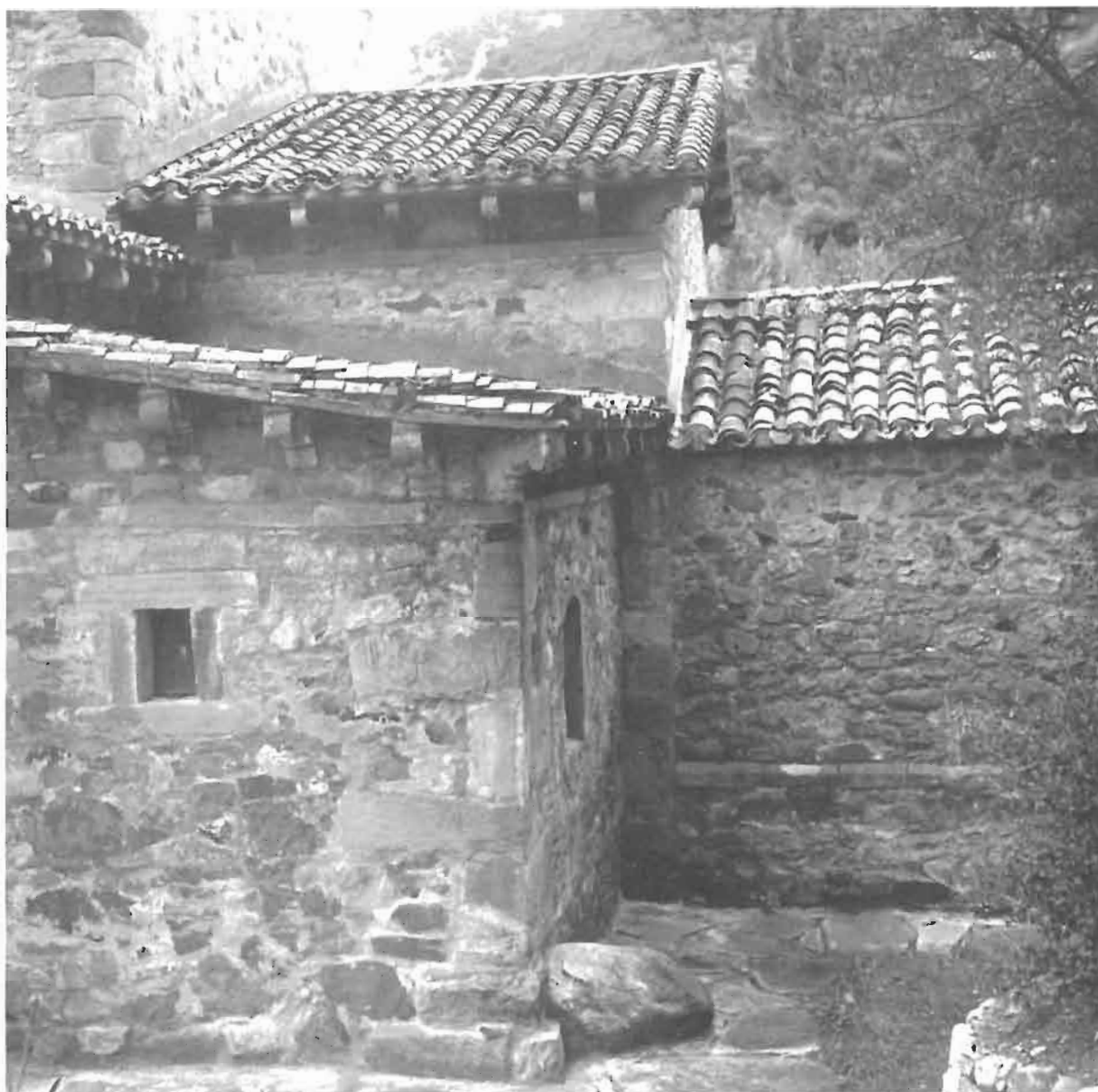
Lám. 7. Fachada norte desde la cabecera.
