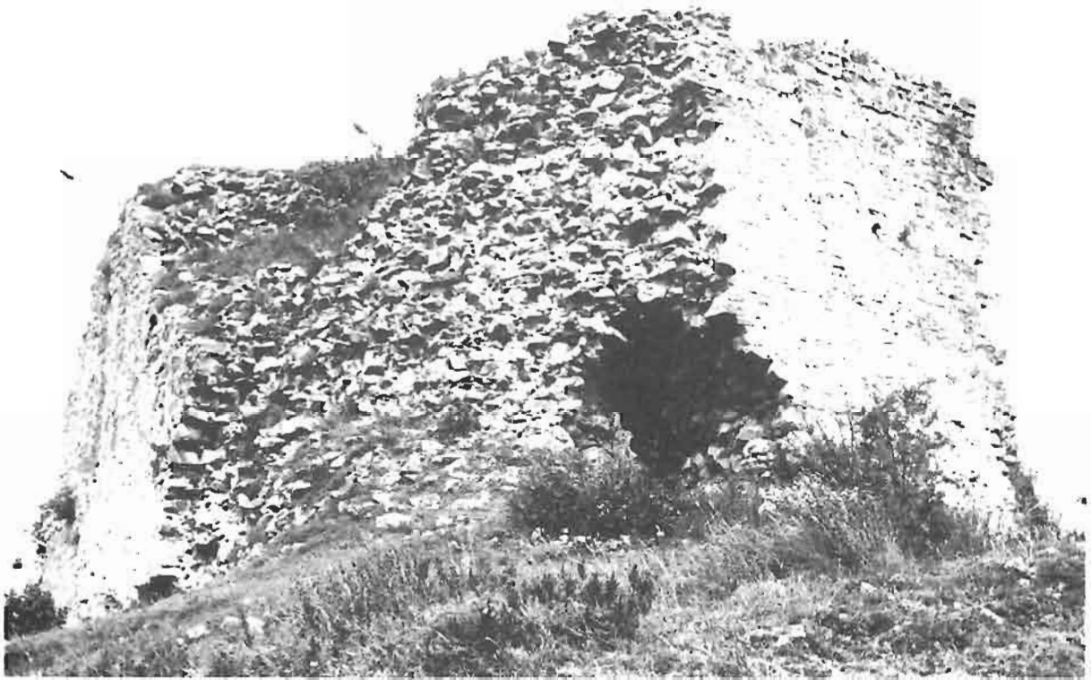
En la esquina suroeste puede verse la perforación por la que se llegó al interior.
