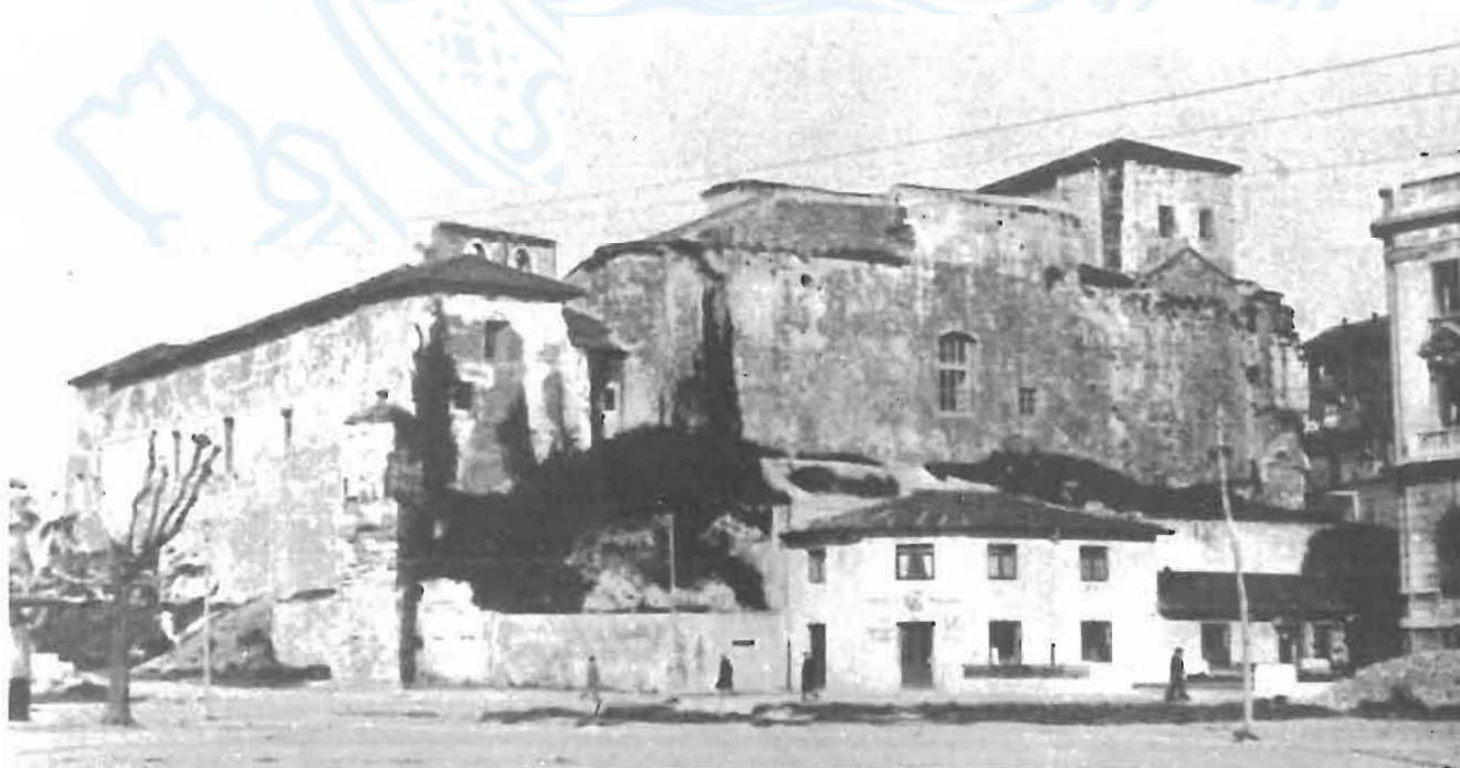
Fachadas sur y oeste después del incendio.
