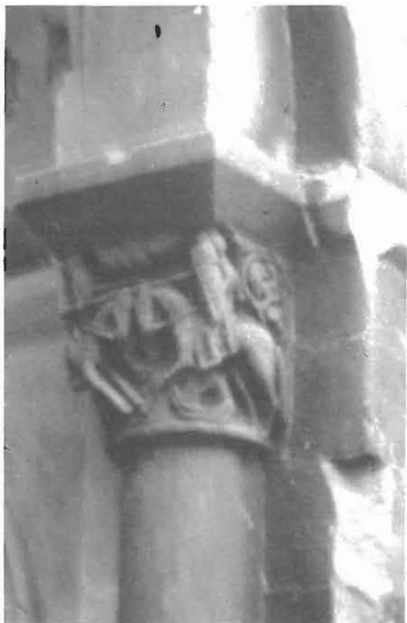
Iglesia de la Villa de Cartes. Capitel del arco triunfal, lado de la epístola. Después del incendio del 18 de abril de 1936.
