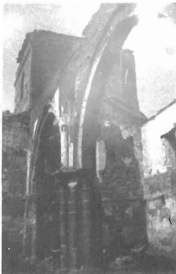
Torre y los dos arcos de unión lateral, de las dos naves.
