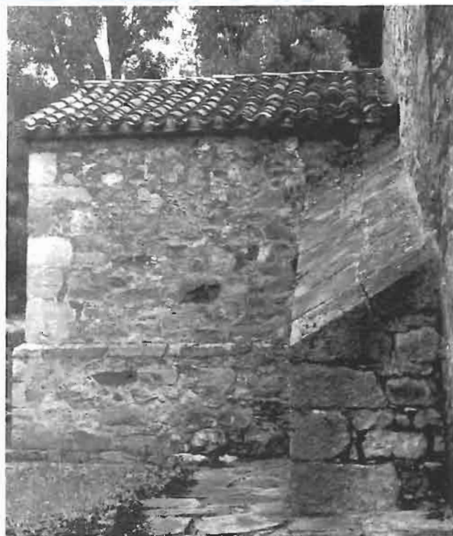
Lám. 6. Fachada norte (sacristía).
