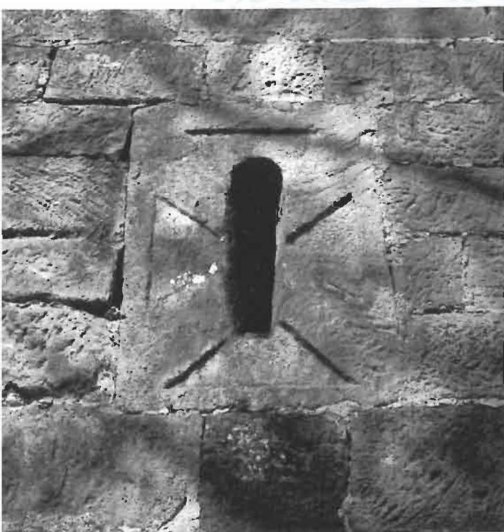
Lám. 43. Exterior. Ventana.
