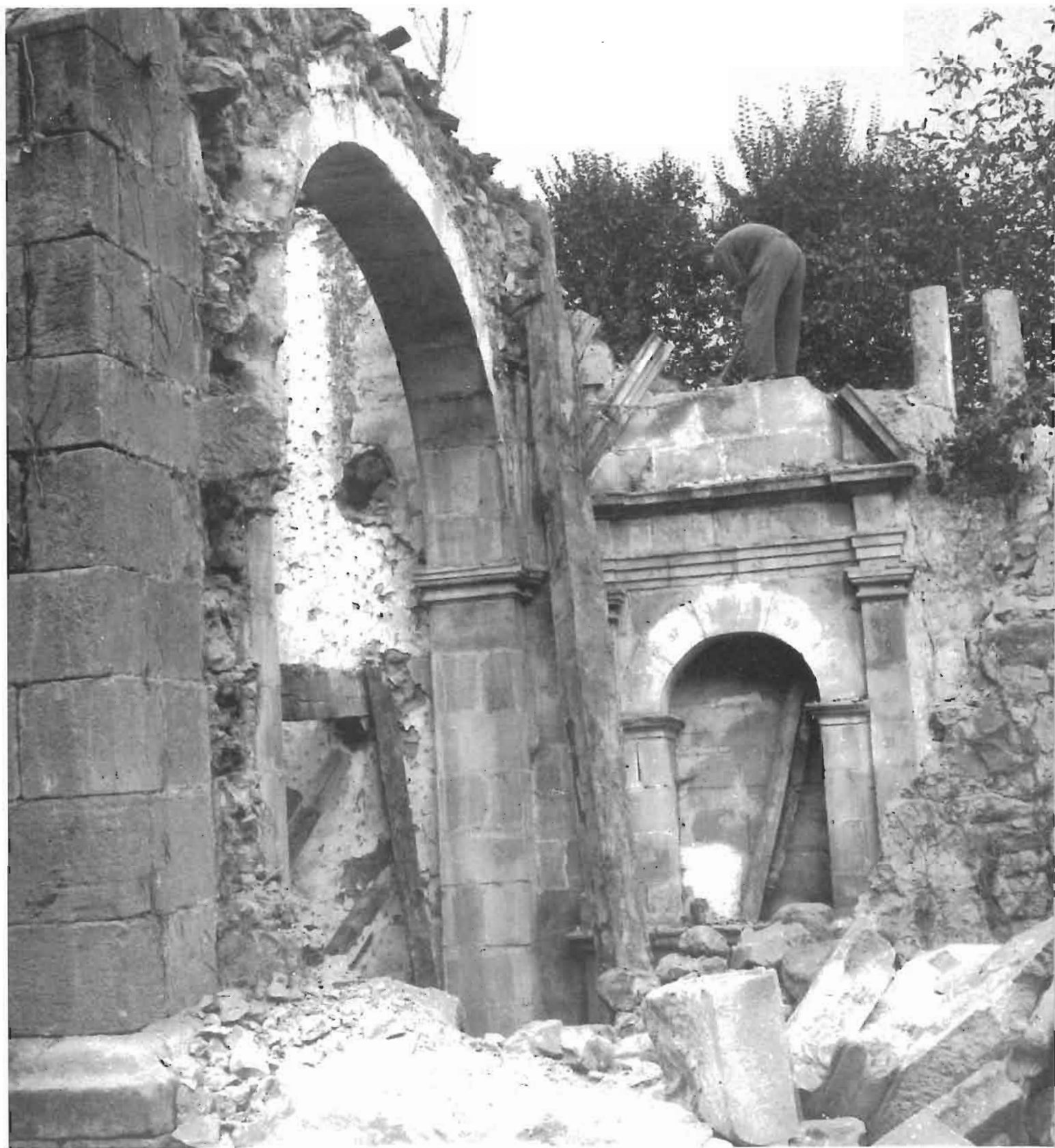
Desmontando la ermita.
