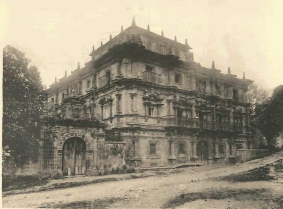
21 — Palacio de Soñanes. Fachadas S. y E. La torre central, linterna de la monumental escalera. Año de 1720.
