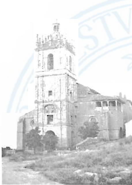
Torre de la iglesia de Támara de Campos obra de Juan de Herrera (1615). Para esta iglesia hizo diversas obras Hernando de la Nestosa y su retablo mayor Fernando de la Peña.
