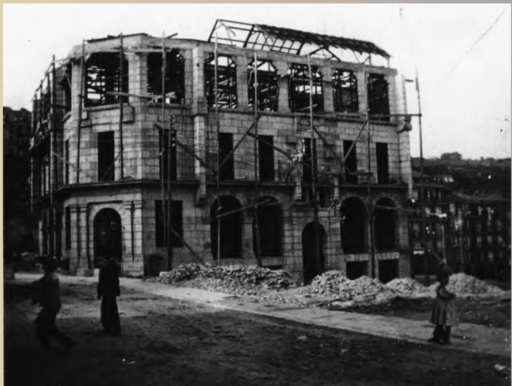
El nuevo edificio del Monte de Piedad de Alfonso XIII y Caja de Ahorros de Santander en construcción.
