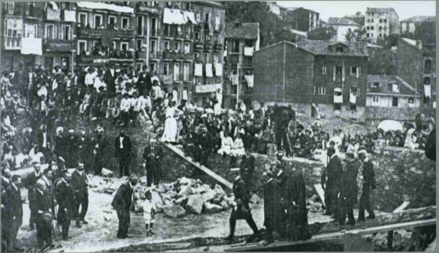
El rey Alfonso XIII coloca la primera piedra del edificio del Monte de Piedad de Alfonso XIII y Caja de Ahorros de Santander, el 31 de julio de 1905. Abajo, el conde de Barcelona en su visita al Centro Cultural Caja Cantabria , en septiembre de 1988.
