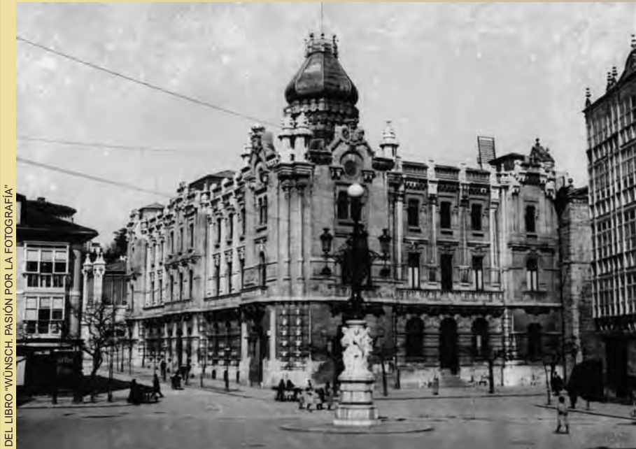
Primitivo edificio del Ayuntamiento de Santander, inaugurado en 1906.
