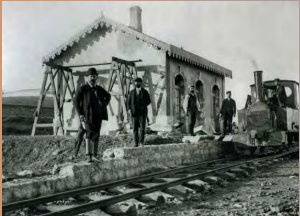
Obras de construcción del primer tramo del ferrocarril del Cantábrico, entre Santander y Cabezón.
