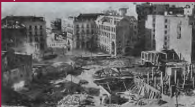
Solar adquirido en 1947 para la construcción de la nueva sede del Monte de Piedad y Caja de Ahorros de Santander.
