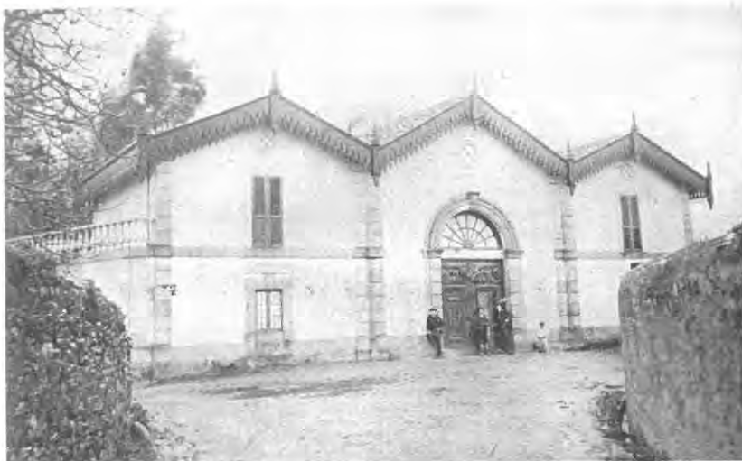
Edificio de la cochera.
