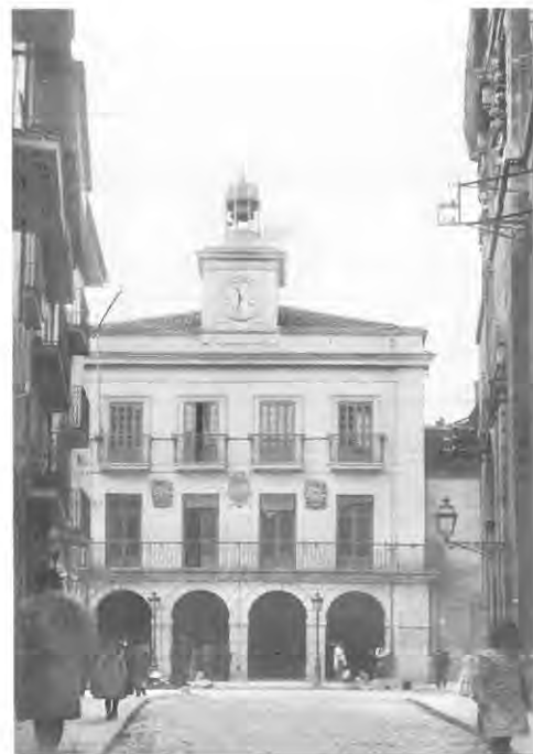
Edificio del Consistorio en la Plaza Vieja.
