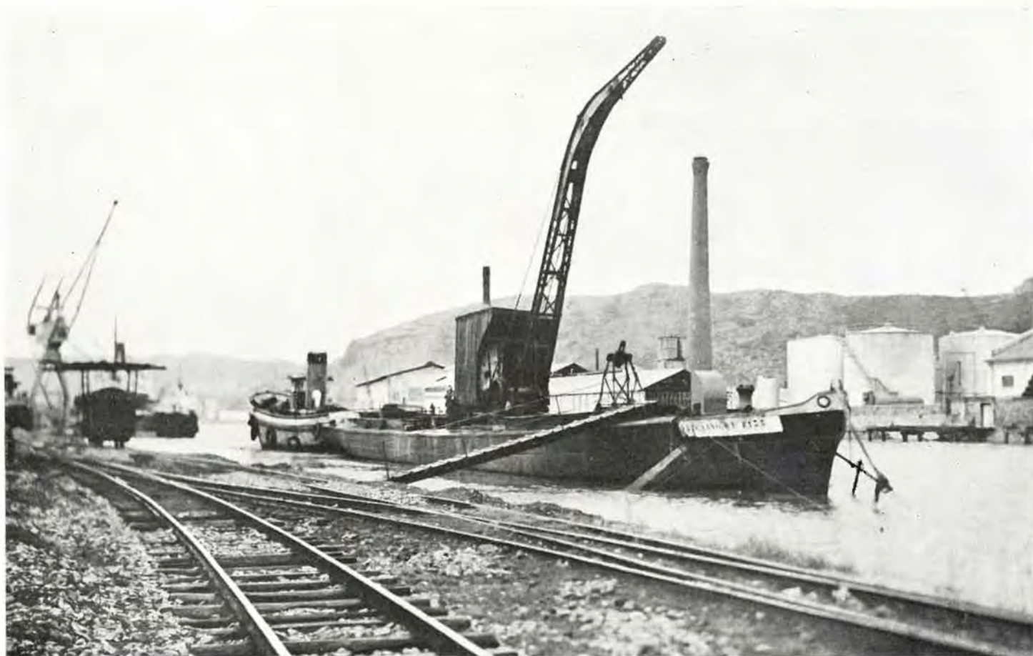
El casco del antiguo vapor correo VIZCAÍNO-MONTAÑÉS, convertido en gabarra-grúa en la Ría de Bilbao, con el nombre de Vizcaíno
