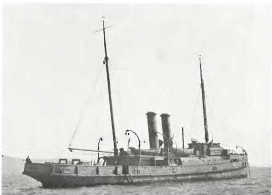
El remolcador de altura CHITA, de Liaño. Se construyó en 1882 para la Armada Real inglesa. Tenía 436 toneladas de registro y se desguazó en Santander en 1933
