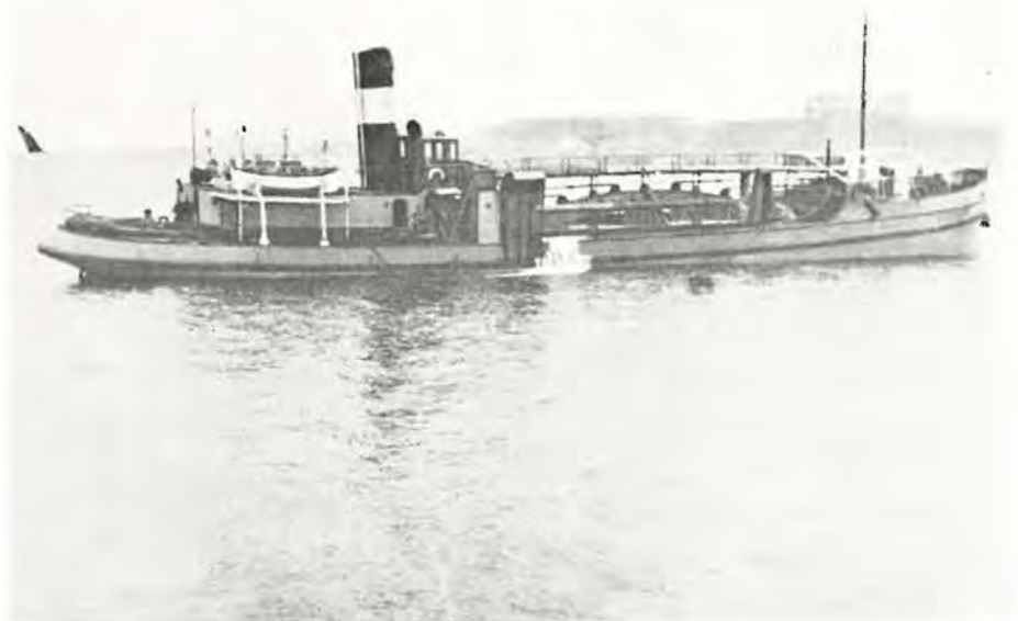
El gánguil Somo de la Junta de Obras del Puerto, a raíz de su transformación en draga de succión. Fue construido en Holanda en 1930
