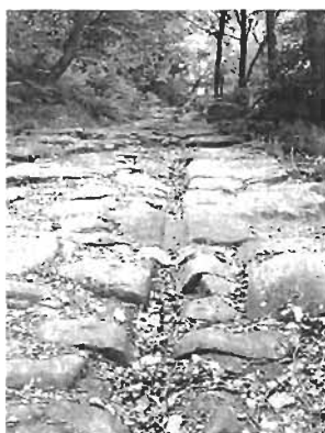
Calzada romana con las huellas de las rodadas de los carros
