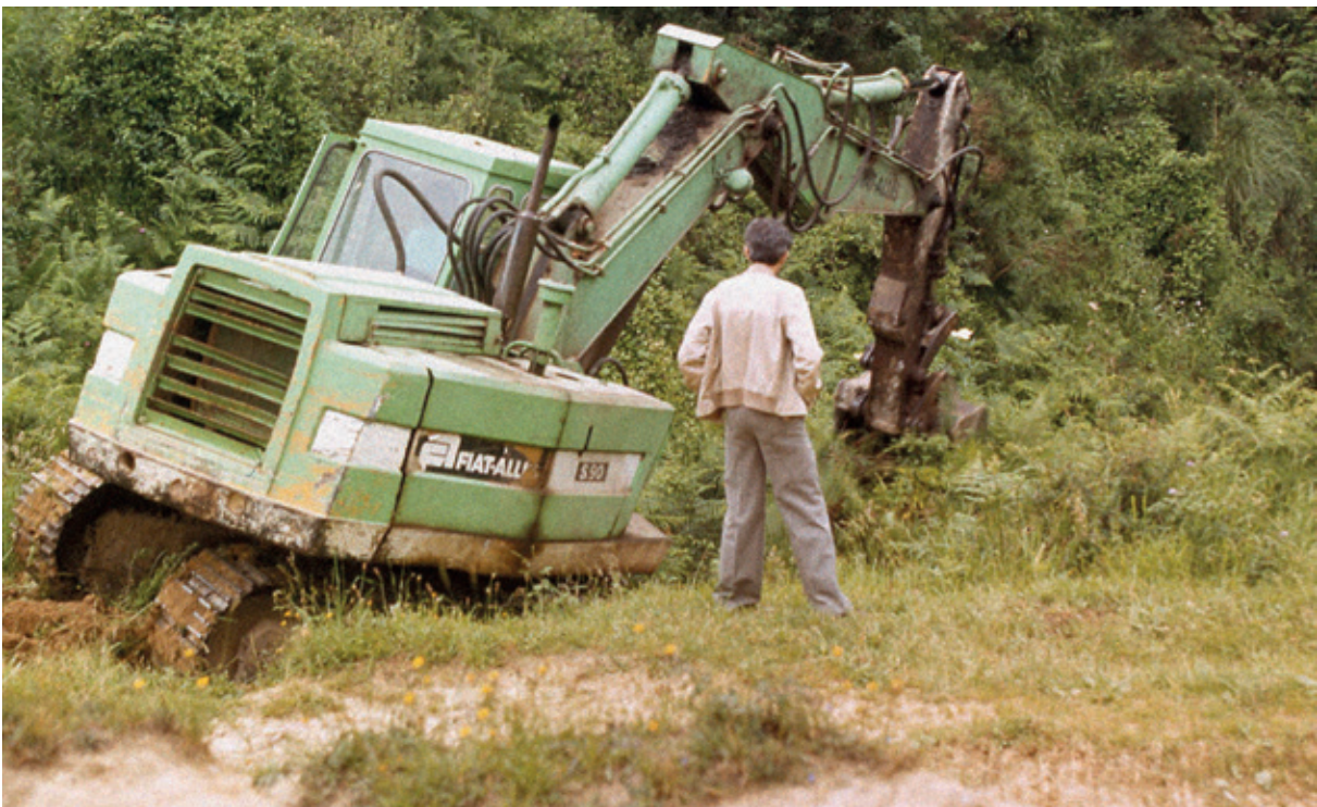
Figura 15. La excavadora atacando el coluvión desde el exterior.
