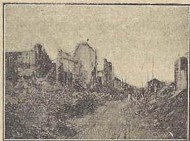
Fig. 351.—Guatemala: ruinas de la 1.ª Avenida Sur.
