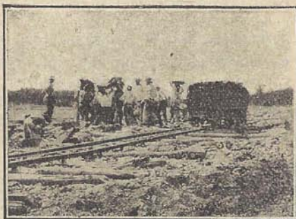
Fig. 167.—Extrayendo bloques del lago de asfalto de la fig. 166. (Fot. comunicada por el profesor venezolano Dr. Eladio A. del Castillo).
