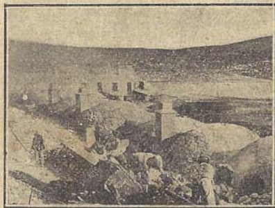
Fig. 118.—Cargando los hornos de primera fusión con las margas azufrosas.
