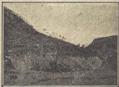
Fig. 287.—Falla, en Castellví (Barcelona), de unos diez metros de alto y con el plano de falla curvo. (Fot. com. por el prof. Dr. M. San Miguel de la Cámara).
