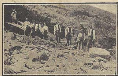
Fig. 269.—Cantera de arenisca en Cabezón de la Sal (Santander): hendiendo la roca con cuñas.
