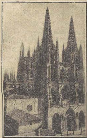
Fig. 146.—La mayor parte de la piedra utilizada en la construcción de la catedral de Burgos es caliza basta de Ontoria (Burgos). (Fot. O. Cendrero).
