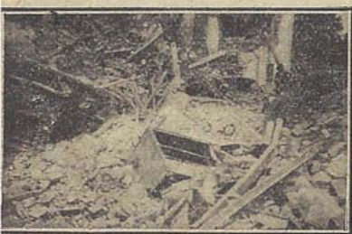
Fig. 357.—Ruinas producidas por el terremoto de Mugello (Italia en 1919. (Fot. comunicada por el Marqués de Maccarani).
