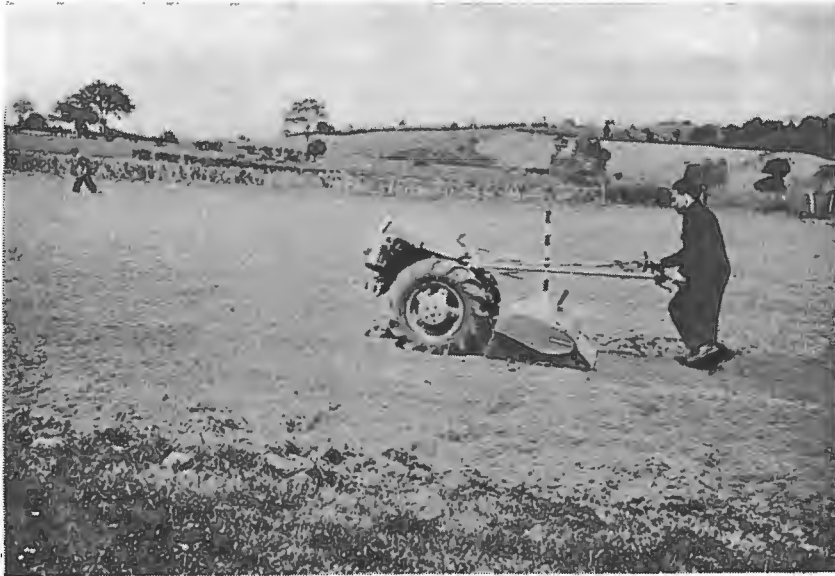
Primer equipo de cultivo rotativo (grada de paletas giratorias) con motocultor en labor previa a la siembra de un campo de ensayo de variedades pratenses en Hoznayo (Entrambasaguas). Marzo 1958.
